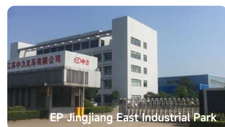
2012 靖江东工业园区
